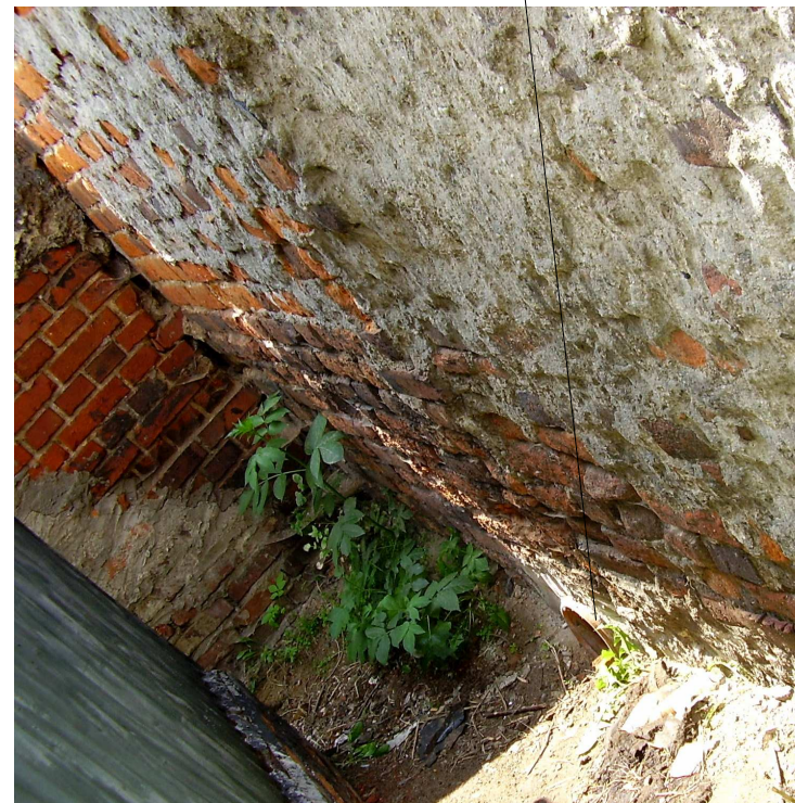
fot. 13 Biała - odcinek miejskich murów obronnych przy ul. Szkolnej Wtórne przebicie pod odwodnienie
