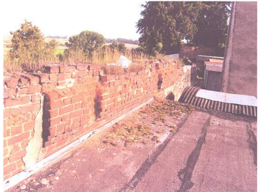
fot. 11 Białe - odcinek miejskich murów obronnych przy ul. Szkolnej Relikty bartyzany - widok od południowego - wschodu
