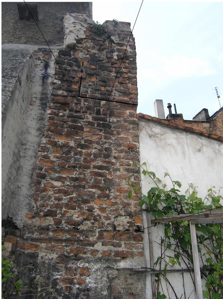
fot. 3 Miejskie mury obronne w Białej Przekrój muru obronnego na zachód od Bramy Prudnickiej - widoczne relikty krenelaża
